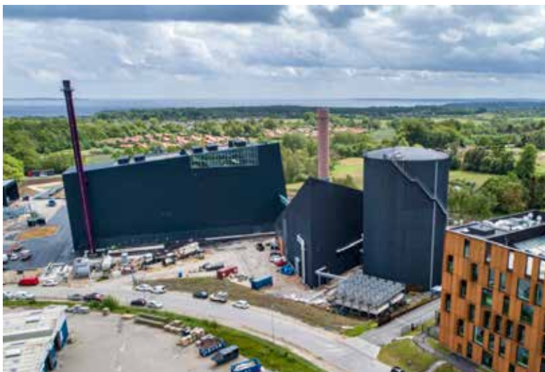
FIGUR 18: VARMEAKKUMULERINGSTANK PÅ HELSINGØR KRAFTVARMEVÆRK
