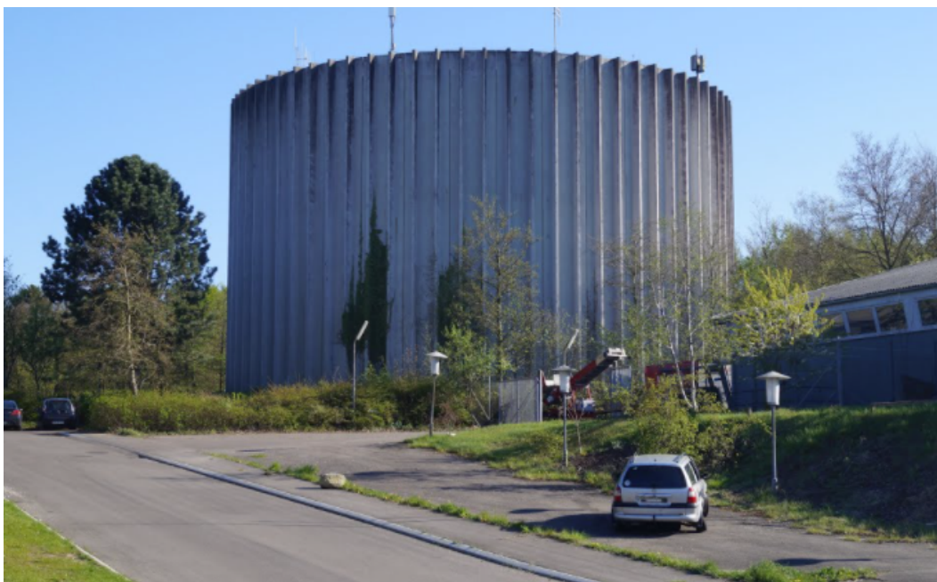
FIGUR 12: 2.800 M 3 VANDTÅRN VED OLE RØMERSVEJ I HELSINGØR
